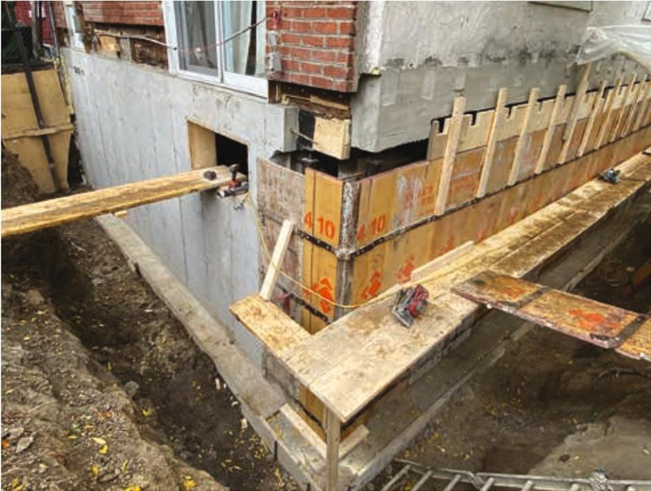
détruire le mur de fondation, puis couler une semelle de fondation au sol sur laquelle on va appuyer et coffrer le nouveau mur de fondation.
