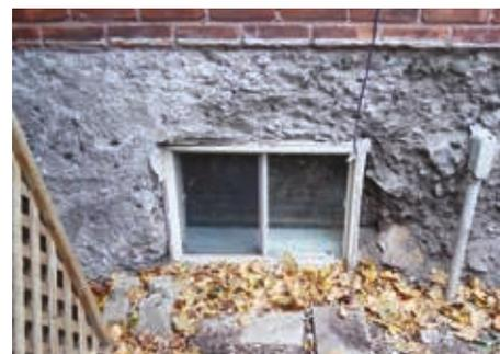
S'il s'agit d'un mur de maçonnerie avec double ou triple brique, ou brique et bloc de béton ou de cendre, on construit une poutre en béton sous le mur de maçonnerie. Ensuite, on peut
