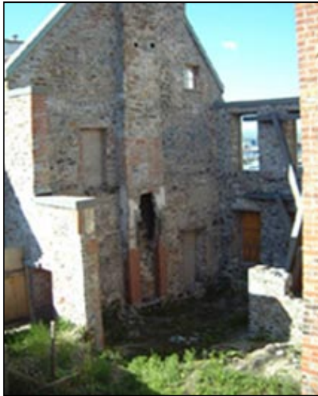
Consolidation des ruines après sinistre
