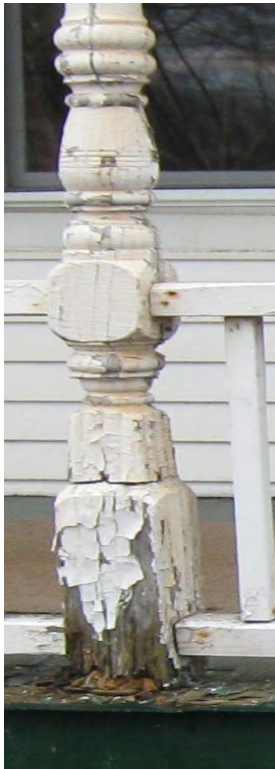
1. L'état d'un poteau.
