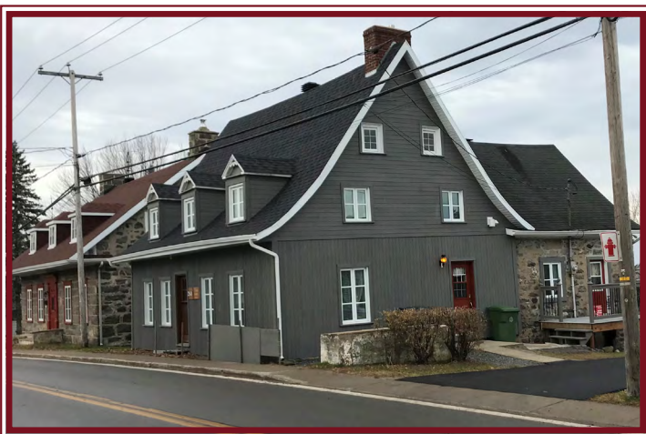
Majestueuse Québécoise située dans la ville de Deschambault-Grondines. Restauration respectueuse du style de la maison construite en 1804.
