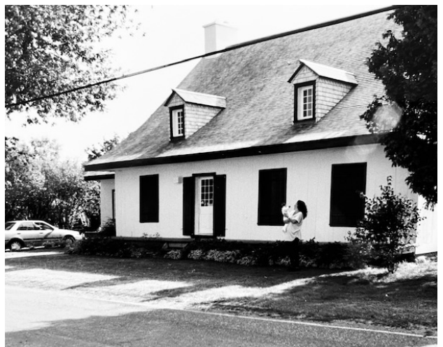
3. Nouveau recouvrement de toiture de bardeaux de cèdre.
