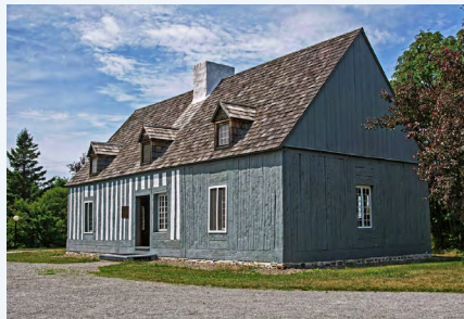
La maison Lamontagne, vers 1744, à Rimouski, exemple rare aujourd'hui d'une structure similaire à celle utilisée à la campagne pour plusieurs maisons et bâtiments agricoles lors des premières 150 années de colonisation au Québec. La partie la plus ancienne de la charpente est à pans de bois (colombage pierroté) et la partie la plus récente (1810) est en poteaux équarris jointifs inspirée vraisemblablement par des constructions anciennes en pieux sur sole. Photo de Nicolas Martel 2017, gracieuseté de La Maison Lamontagne.
