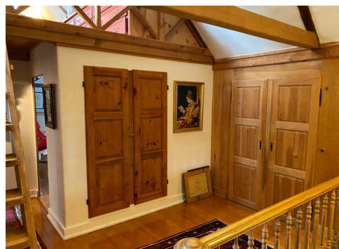
3. Le gros œuvre construit en pin.
