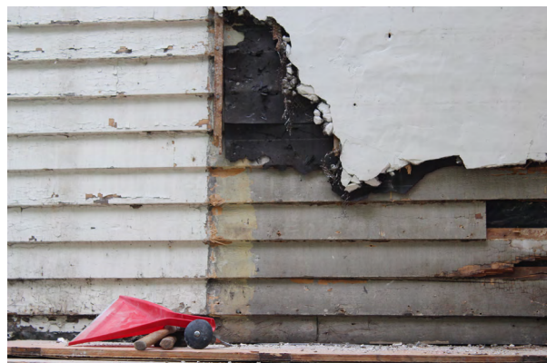
3. Retrait du corps d'enduit recouvrant le clin de bois.
