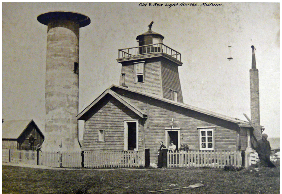
5. Le phare de Matane lors de la construction de la tour en béton armé en 1907. À droite, on retrouve l'ancien phare de bois et la maison du gardien. Photo : Archives nationales du Canada
