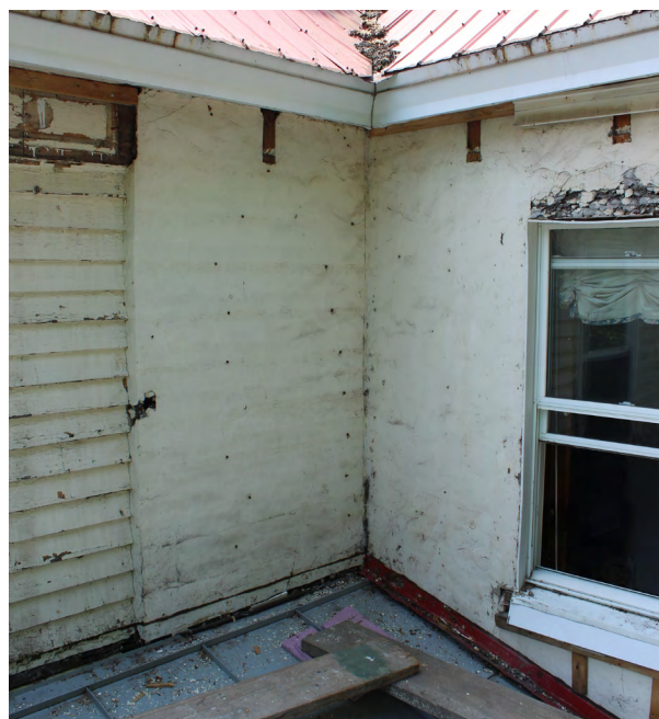
2. Le coin est dépareillé par un épais enduit en béton.
