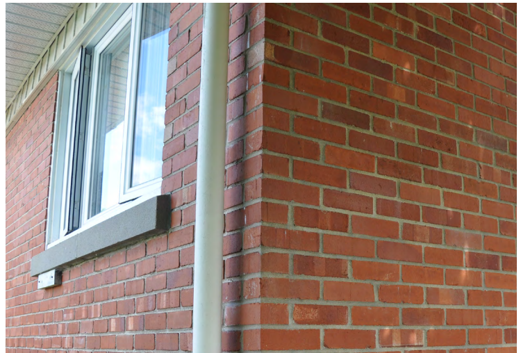
Mur à droite démonté et remonté, mur de gauche conservé, d'origine.
