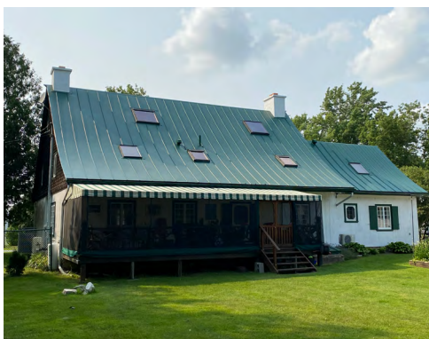
4. Installation de six châssis à tabatière.
