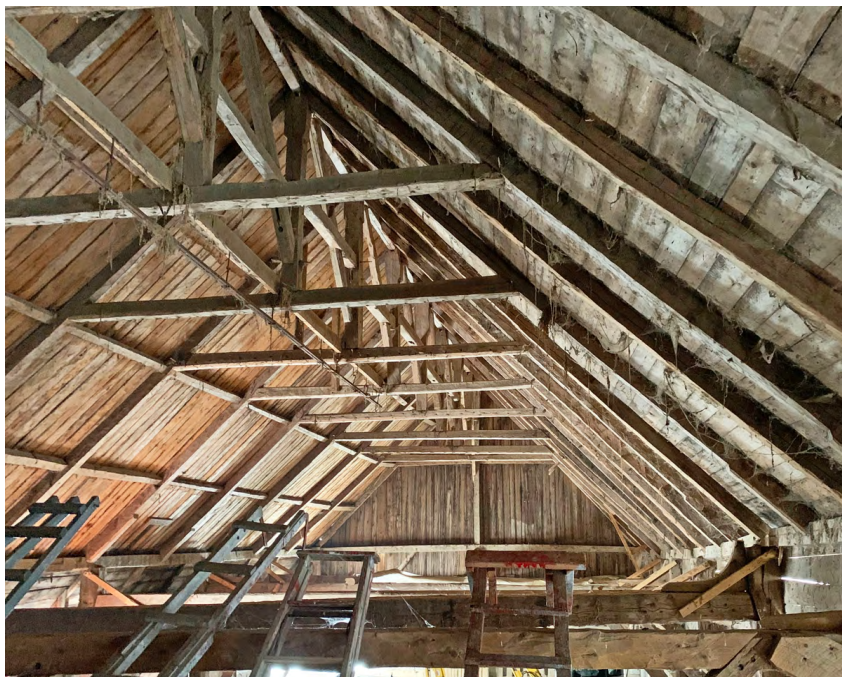
5. Quelques rares tentatives afin de combiner la grange et l'étable se trouvent dans certains actes notariaux au début du XVIII e siècle, mais je crois que cette nouvelle forme de construction, la grange-étable longue et sa prolifération, typique de l'architecture québécoise plus pratique et adaptée au climat du Québec, n'apparaîtra qu'après la fin du Régime français. Cette magnifique grange-étable multifonctionnelle de 144 pieds de longueur, construite vraisemblablement avant 1800, a appartenu à plusieurs générations de la famille Canac-Marquis. Muni d'une charpente à la française complète, le toit du versant nord est composé d'arbalétriers interposés, de chevrons orphelins et de planches horizontales; le versant sud incorpore des chevrons arbalétriers, des pannes et des planches verticales. Plusieurs éléments proviennent d'un bâtiment agricole plus ancien.
