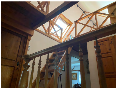
1. Construction de deux niveaux.
