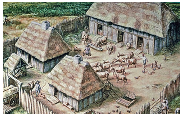
3. Jusqu'au milieu du XVIII e siècle, plusieurs maisons et les bâtiments agricoles étaient construits à pans de bois, hordés de torchis (mélange terre - paille). En 1626 au Cap-Tourmente, Champlain et Guillaume de Caën font ériger des logis et une étable de 60 x 20 pieds, «à la gasparde» (couverte de paille), pieux verticaux, espacés d'un mètre, bousillés de blocs d'argile du lieu. Aquarelle de Francis Back, Musée de la Civilisation, Québec.
