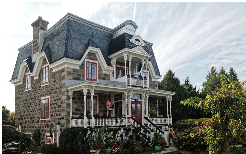
La maison Benoît-Tremblay située au 5285, chemin de Chambly. C'est l'architecte Alfred Fournier dit Préfontaine, né à Longueuil (1865-1910) qui a dessiné les plans de cette imposante demeure de courant victorien (fin du XIX e siècle) possiblement construite pour Alexis Tremblay et habitée par son fils, Alfred Tremblay. Pierre-Basile Benoît, premier député du comté de Chambly, y aurait vécu.
