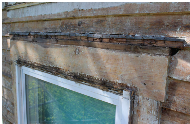
1. Condition de la traverse couronnant la fenêtre. On remarque la bande du solin en tôle d'acier servant de couvre-joint d'étanchéité.
