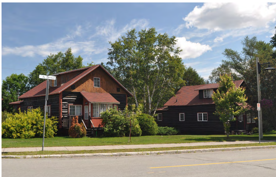
Ensemble de maisons de l'avenue Perrault.
