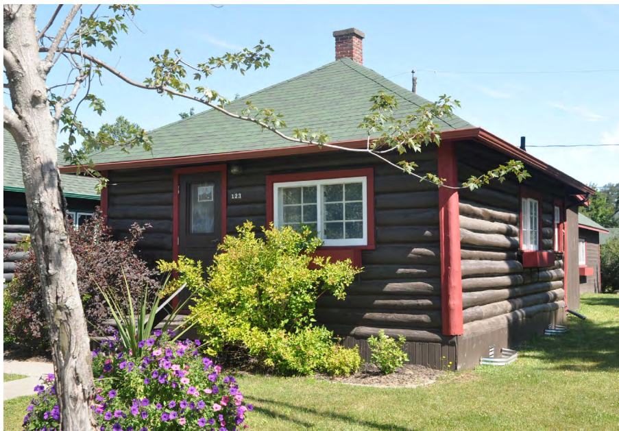
Centre d'interprétation avec son toit à quatre versants couvert de bardeaux d'asphalte.
