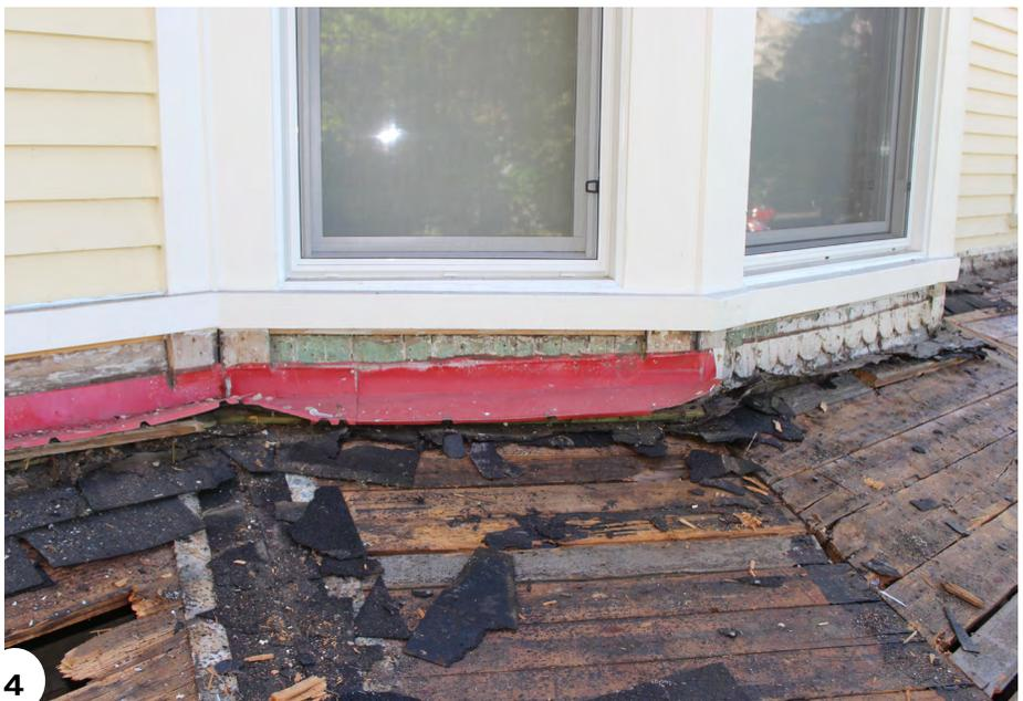
La surface dépouillée du versant présente des signes d'affaissement à quelques endroits (ill. 5). Il faut donc retirer des planches pour accéder aux combles afin de consolider les chevrons et ajuster la pente du toit en appentis. J'y plonge mon regard; c'est ouvrir une capsule temporelle, vieille de 94 ans! J'immortalise en photo le savoir-faire de nos artisans. Ce vestige ornemental est composé de bardeaux de cèdre en écailles de poisson (ill. 6).
