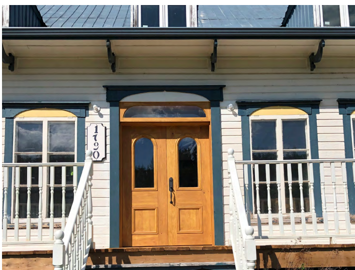
Modification de la porte principale double avec imposte.
