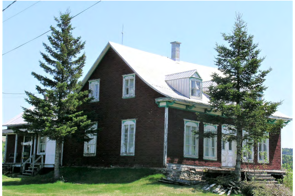
La maison sise au 1790, rang Saint-Étienne-Sud, à Sainte-Marie dans la MRC de La Nouvelle-Beauce. Source : Ville de Sainte-Marie, inventaire des bâtiments patrimoniaux 2003-2004 — photo 793.
