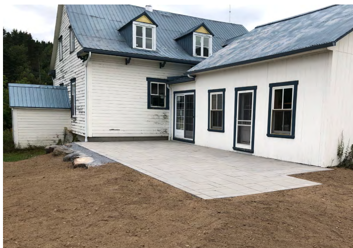
État de la cuisine d'été, en 2019, après restauration.
