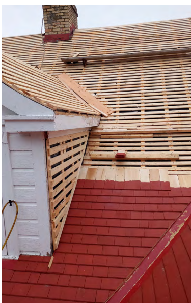
Détail de la structure de voliges à claire-voie. Photo Bernard Chapais.
