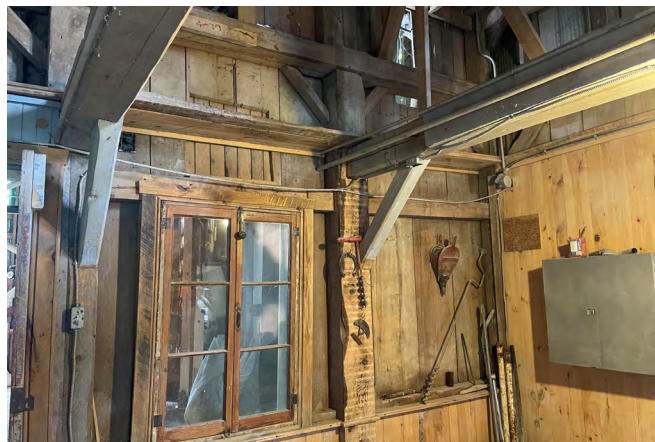
Vue de la structure à l'intérieur du moulin.
