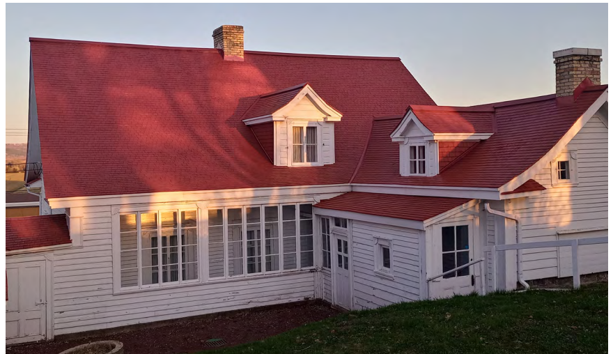
La nouvelle toiture. Photo Bernard Chapais.
