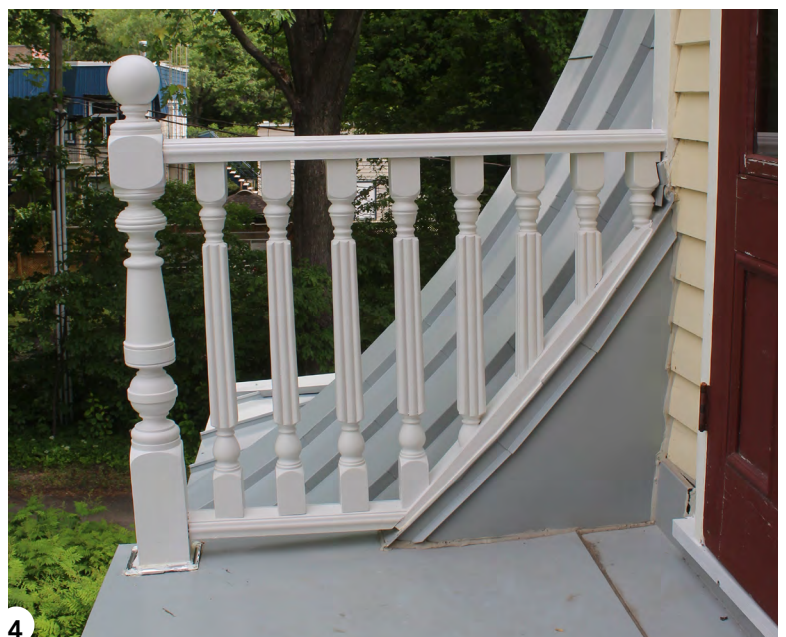
4 Vue de l'assemblage d'une première section.
