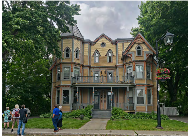
La maison Tellier. Cet immeuble à deux logements fut construit pour l'honorable juge Louis Tellier. Il offre une profusion d'éléments architecturaux qui témoigne de l'éclectisme du courant victorien.
