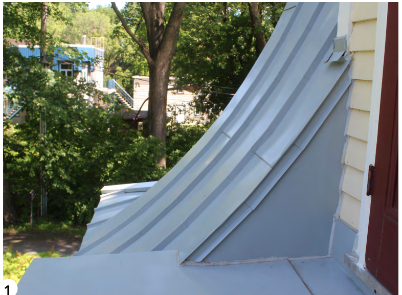
1 Le plancher du balcon s'enclave dans la pente de la toiture en tôle pincée.
