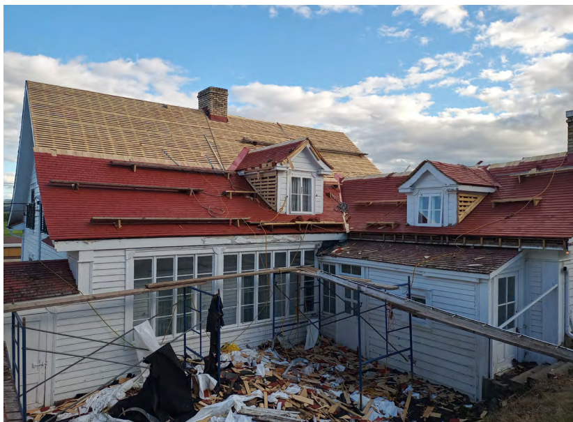
La réfection des toitures du côté nord de la grand'maison. Photo Bernard Chapais.
