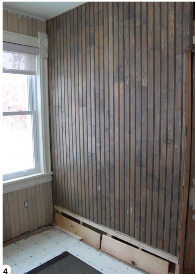
4 Le surplus de planches emboutetées en pin jointé du revêtement extérieur devient le parement des murs du vestibule.
