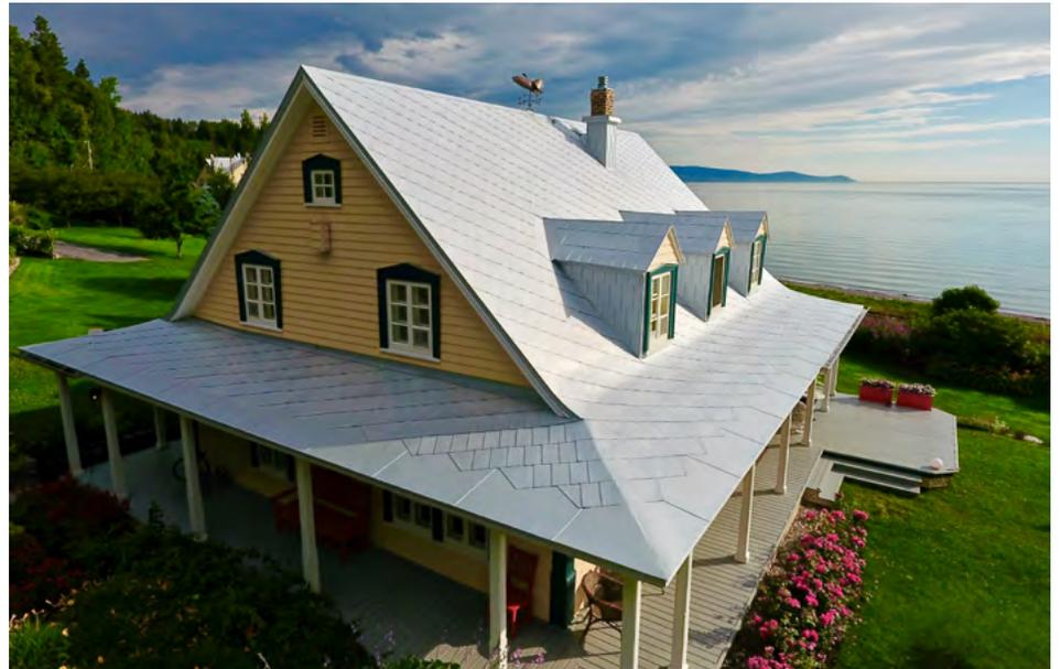
*Couverture de tôle à la canadienne. Les joues des lucarnes sont recouvertes du même matériau.*
