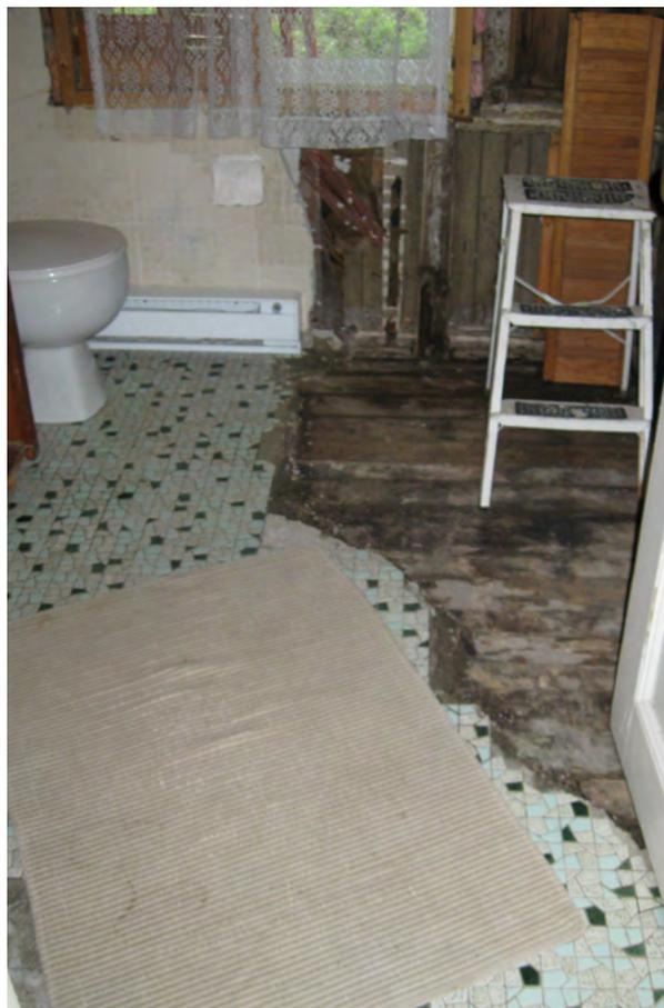
*L'étendue des dégâts sous la couche de céramique de la salle d'eau. L'infiltration d'eau a aussi affecté le bas des murs.*
