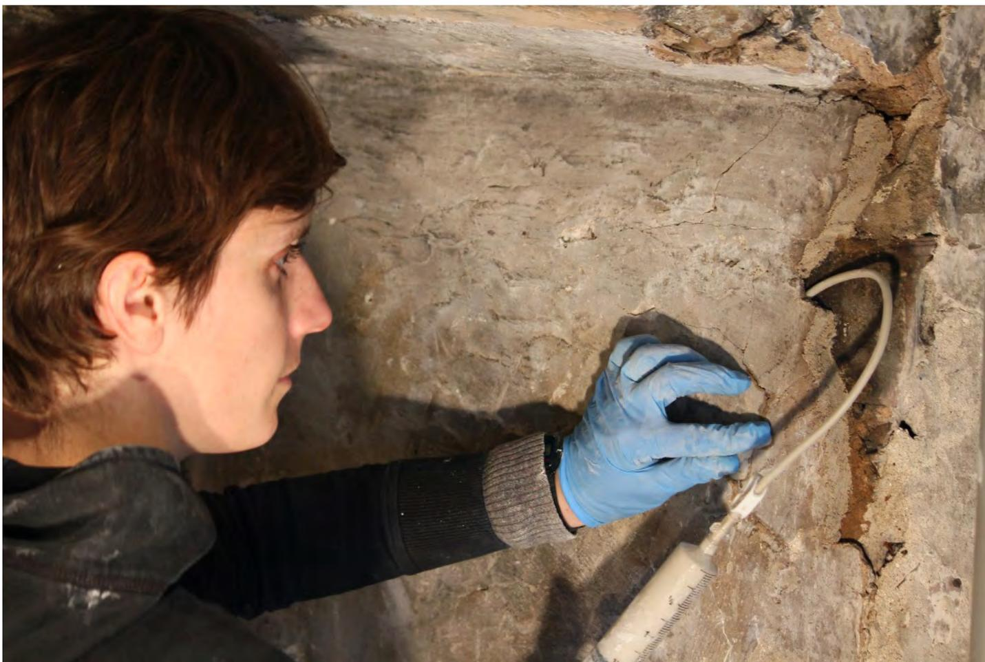
*Injection de mortier dans les sous-couches d'enduit qui présentent un décollement.*
