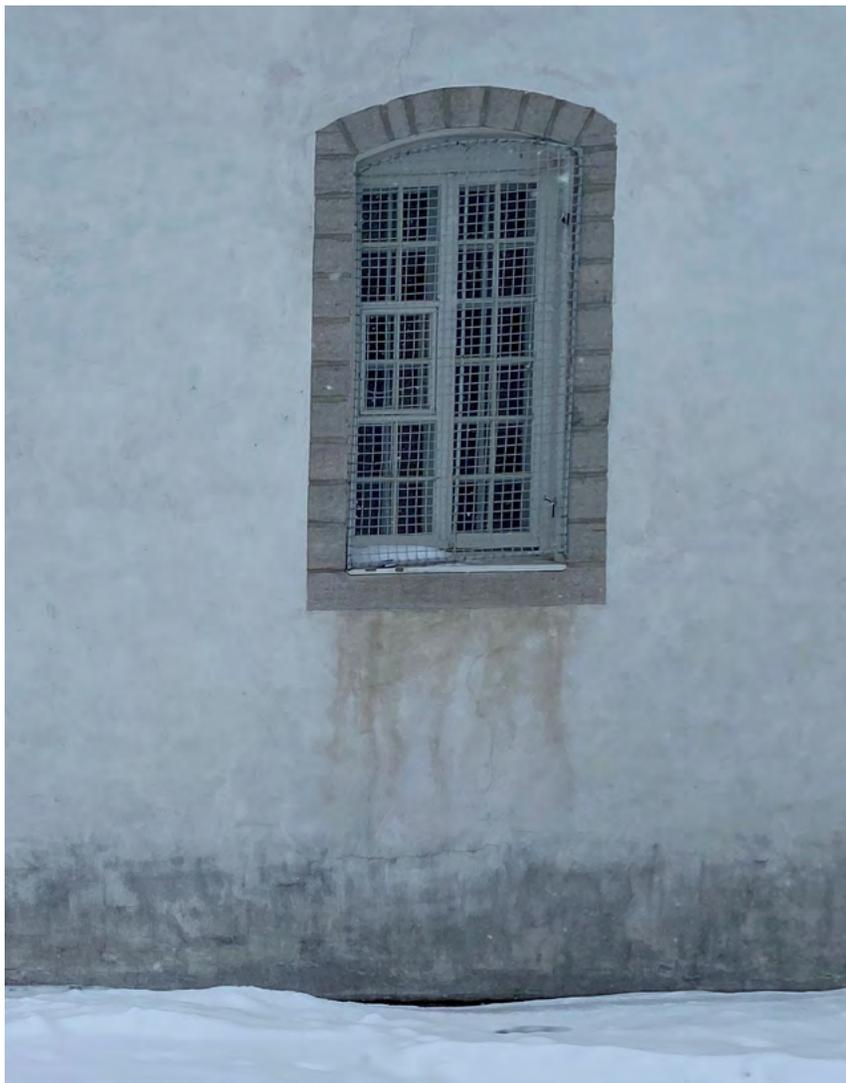
*Croissance de microorganismes dans le bas du mur (bande noire) et sous les tablettes de fenêtre (coulures orangées).*
