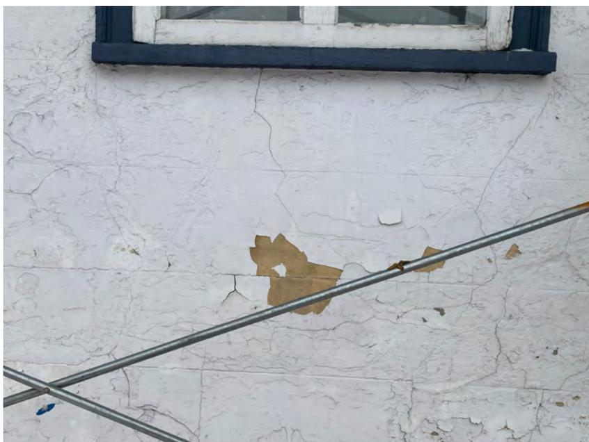
*Soulèvement de la couche de finition (peinture) dû à une incompatibilité avec l'enduit.*
