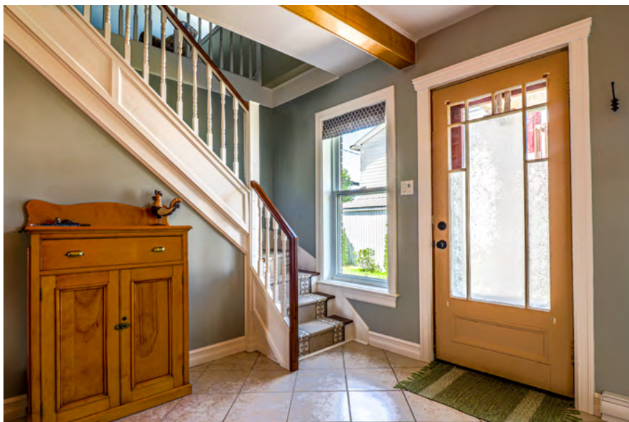
Après - L'escalier restauré.
