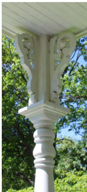
Poteau de coin de la galerie
