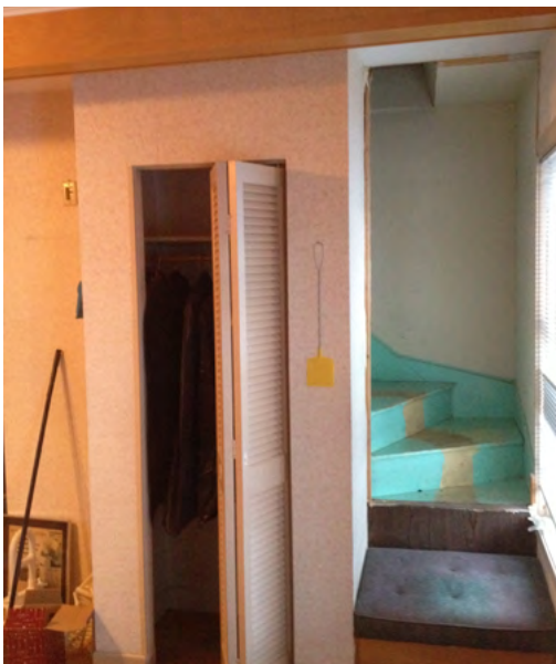
Avant - L'escalier emmuré.
