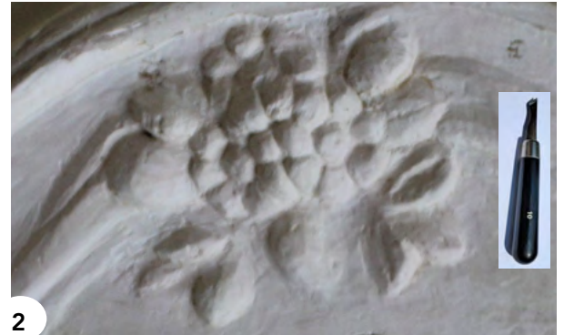
La peinture est retirée à l'aide d'un couteau à linoléum.
