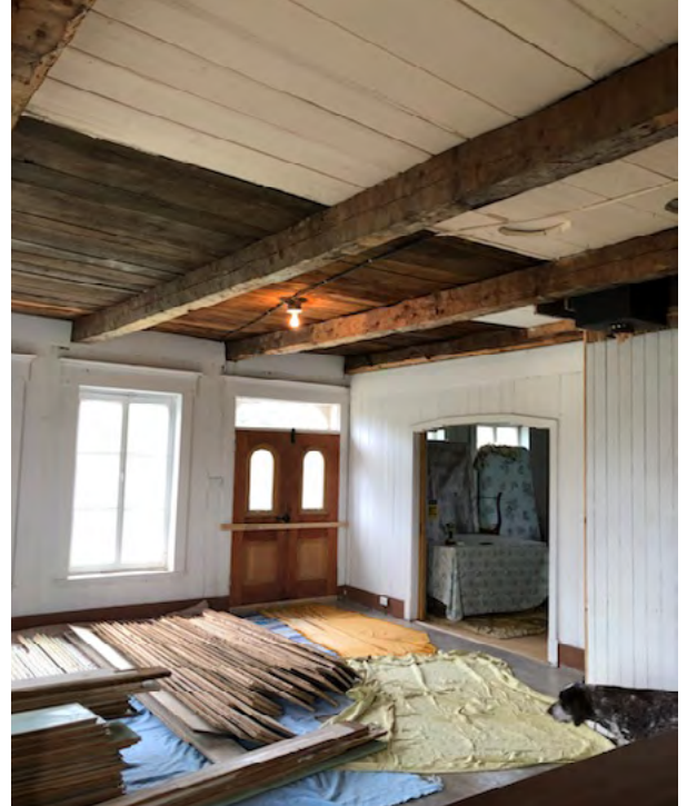
Le plafond du rez-de-chaussée avant sa restauration.
