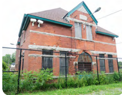
Le château d'eau construit en 1893.
