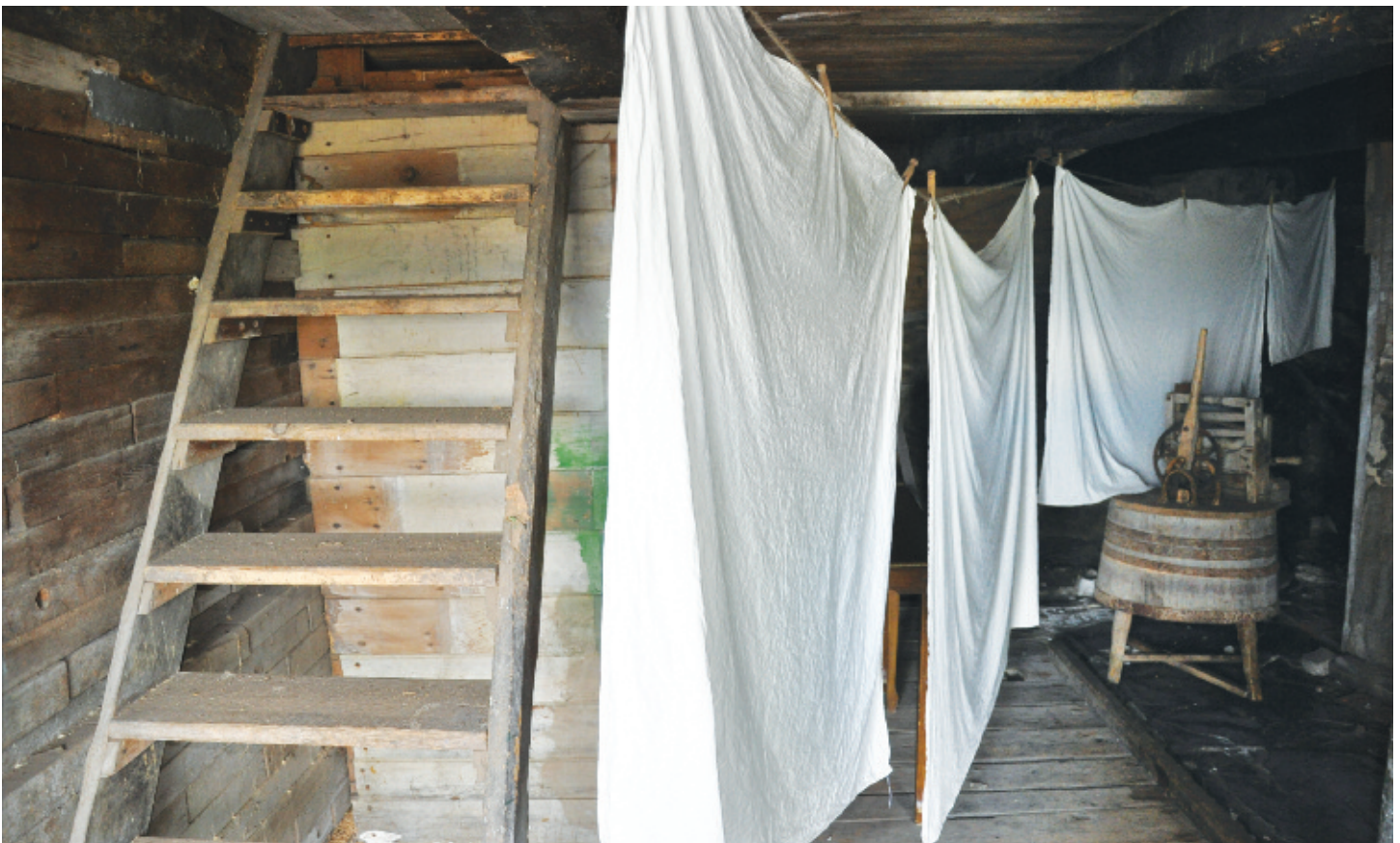
Usage du vide sanitaire, Maison Chapais, 1833, Saint-Denis-de-la-Boutellerie.
