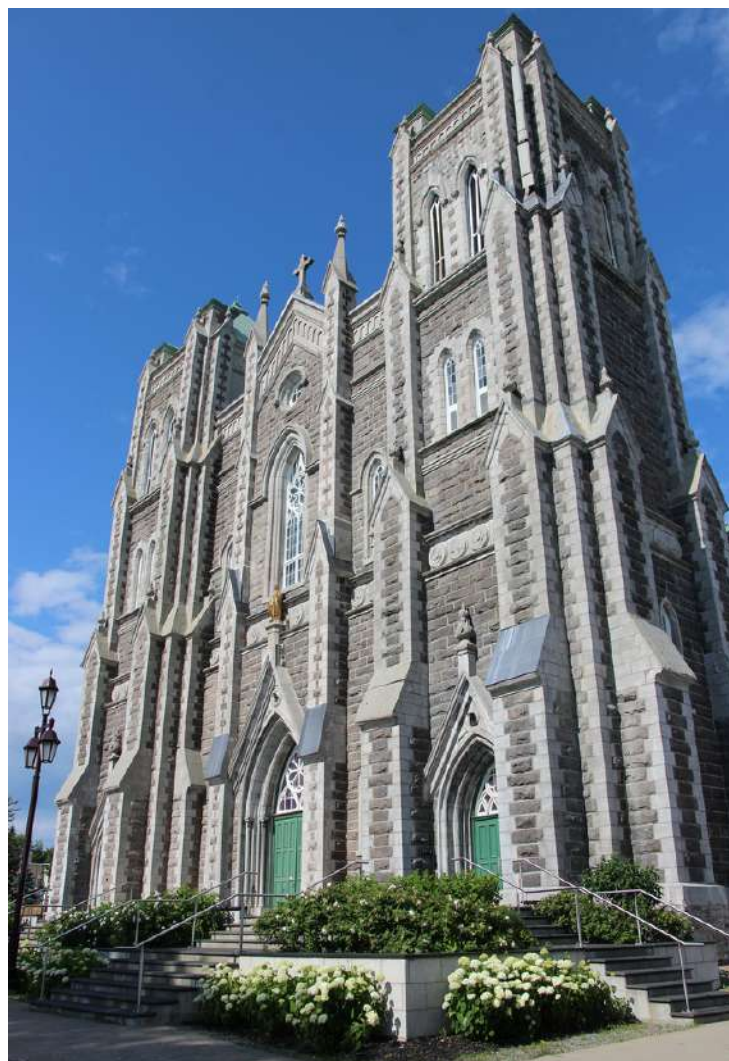
Restauration de l'église de la Nativité-de-Notre-Dame de Beauport, 2010 jusqu'à aujourd'hui. crédit : Marie-Josée Deschênes, architecte
