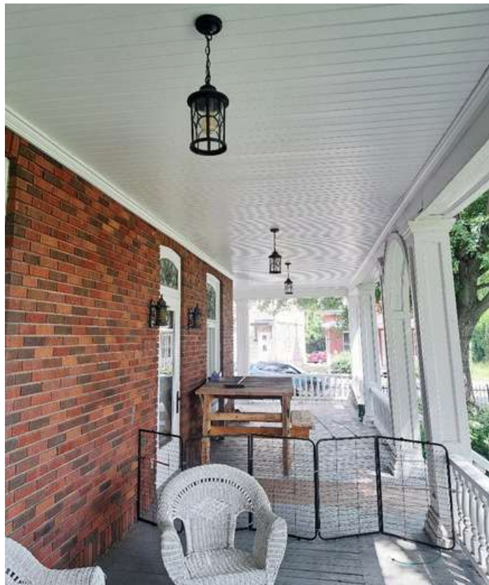
Vue de la galerie, après restauration.
