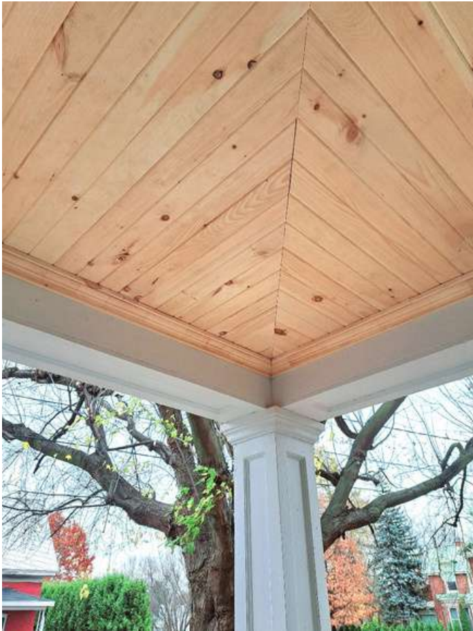
Le plafond de la galerie après restauration
