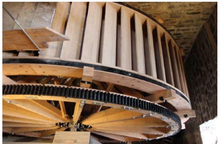
Reconstruction de la roue à godets du moulin à eau de la Seigneurie des Aulnaies, 2020-2022. crédit : Marie-Josée Deschênes, architecte
