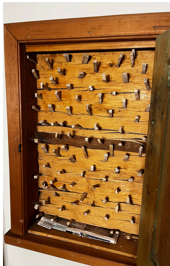
Une « fenêtre sur le passé » montrant un picotis de chevillettes insérées dans la structure de pièce sur pièce, servant à retenir la couche de plâtre, avant l'usage du lattis.
