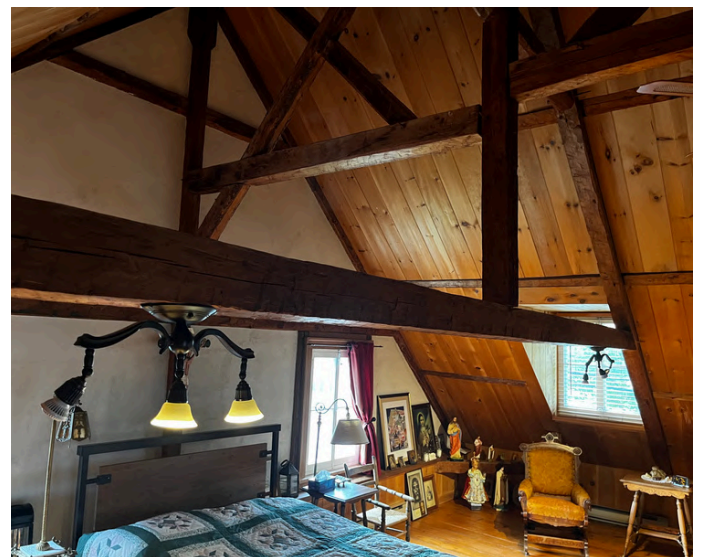
Vue de l'étage montrant la magnifique structure du toit à la française
