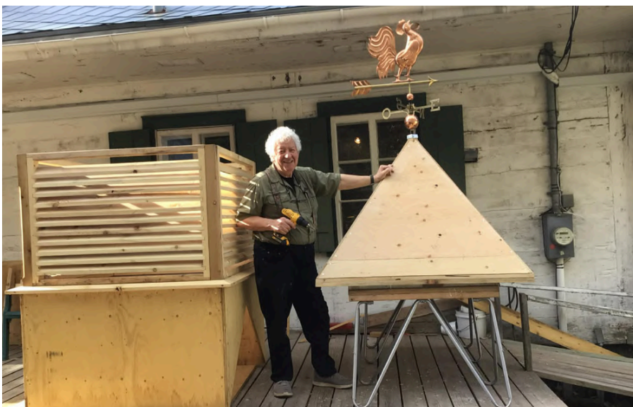
Ronald Du Repos au travail sur la toiture du campanile
