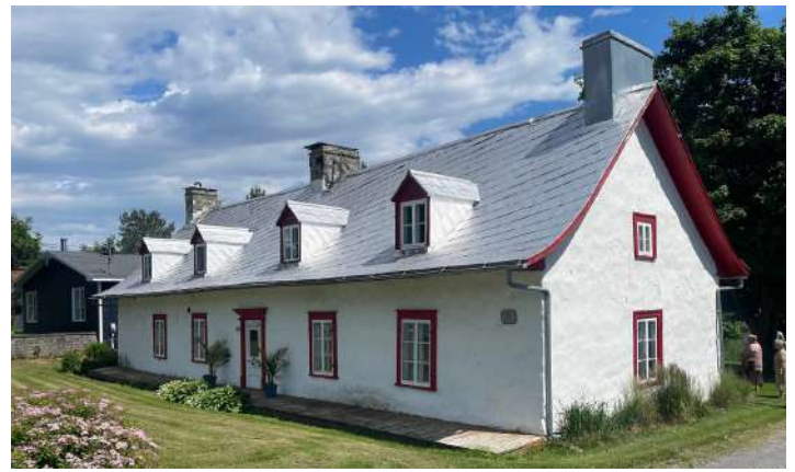
Vue de la façade sur rue de la maison Blais-Leroux
