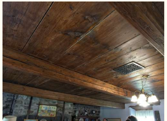
Vue du plafond et de la charpente
