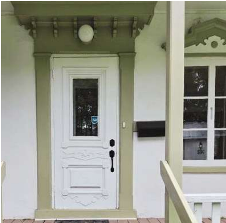
Porte principale ornée d'appliques et pourvue de chambranles et de corniche à consoles
