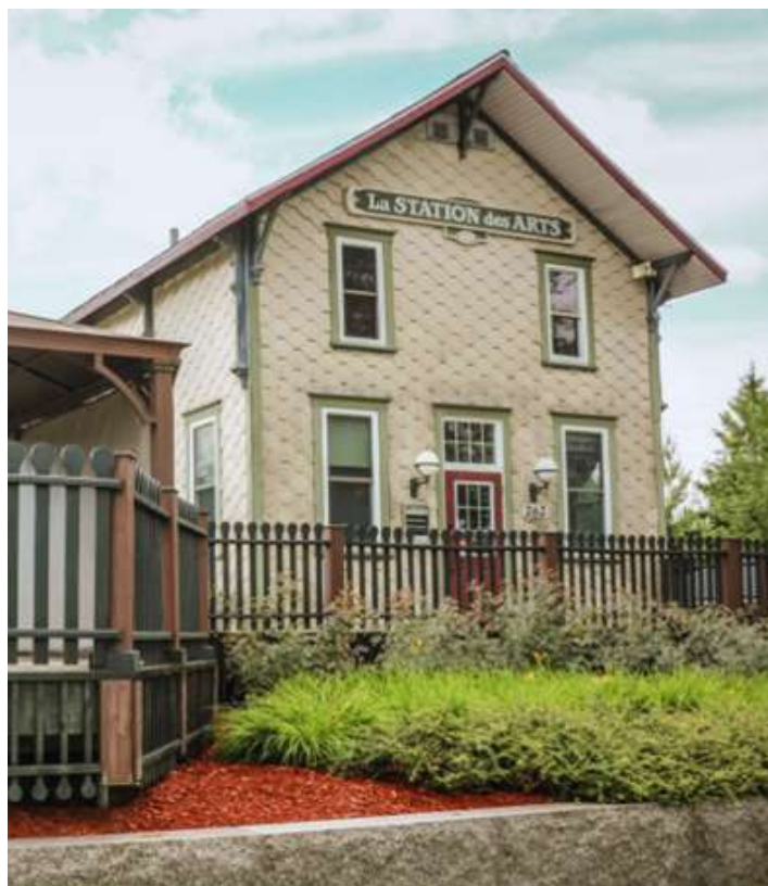
La Station des arts de Thetford Mines est le résultat concret de la sauvegarde et de la mise en valeur de la plus ancienne gare de la région. Elle est inscrite à l'inventaire de la MRC des Appalaches
