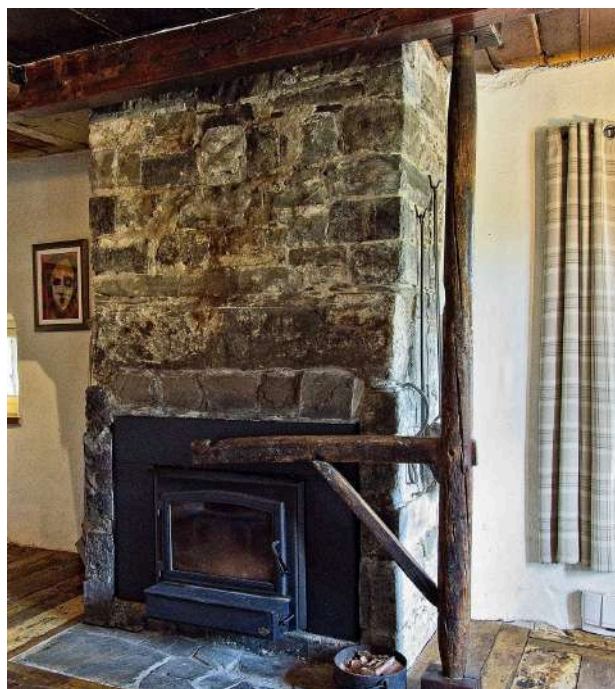
Vue du foyer dans la salle à manger
