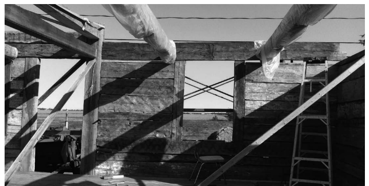
Les pièces de bois réparées ou refaites à l'ancienne ont été insérées dans la coulisse des poteaux intermédiaires verticaux. Les pièces sont assemblées à queue d'aronde dans les coins. La dernière pièce du mur qui est en train d'être mise en place embarde les poteaux intermédiaires ainsi que les poutres, ici protégées de la pluie par une pellicule plastique. Ainsi tout est solide, sans clou!
