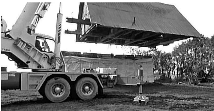
Le toit est soulevé d'un seul bloc avec une grue. Vidéo disponible à www.maisons-anciennes.qc.ca
