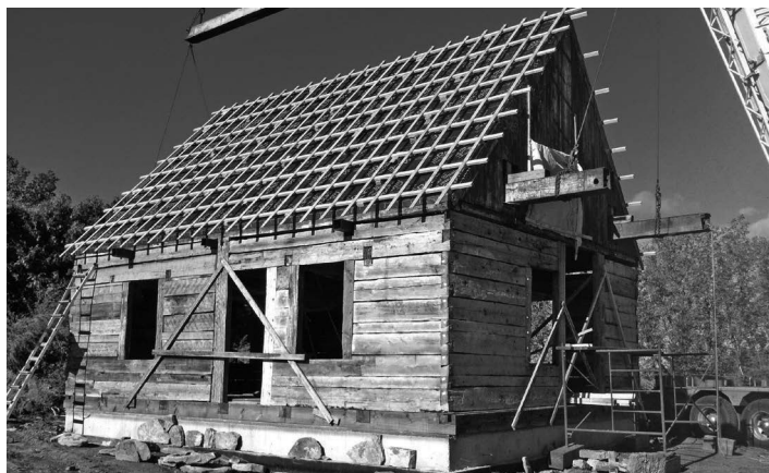
La maison restaurée a retrouvé ses ouvertures à l'emplacement d'origine et se marie parfaitement au toit qui reprend sa place.
