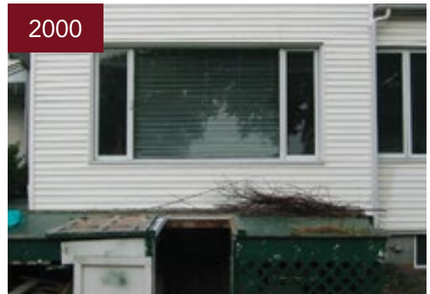
2000 Un lourd panneau en contreplaqué fixé à l'aide de charnières est posé sur le plancher d'une terrasse. Il recouvre les marches en béton de la descente de cave. © Pierre Bleau
