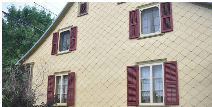
Maison du 19 e siècle située à Grondines, couverte de panneaux d'amiante-ciment en forme de losanges. Les fenêtres d'origine sont munies de jalousies ©Clément Locat
