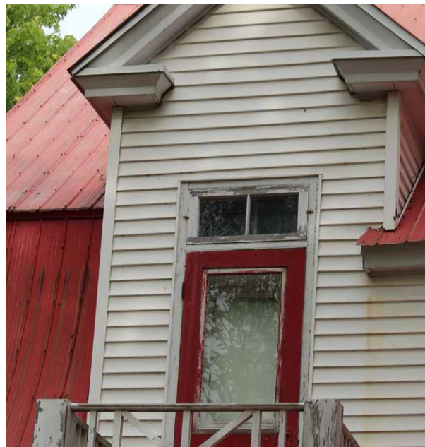
État du fronton de la porte-lucarne recouvert d'une pelure vinylique au début des années '80.
