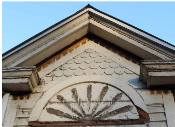
État des rayons de soleil sous le revêtement de vinyle.
