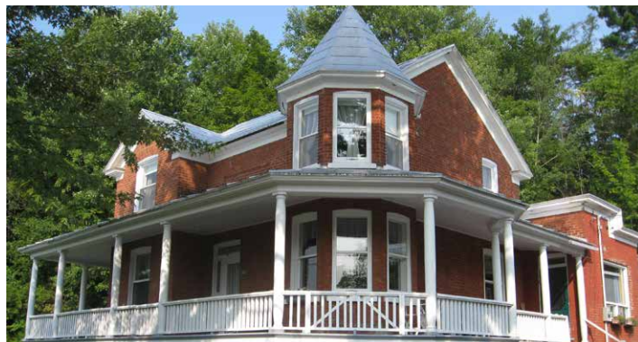
Maison datant de 1915, située à Saint Barthélemy, ayant conservé tous ses éléments d'origine: Fenêtres à guillotine, tôle d'acier sur les toitures et parement de brique. La galerie et sa balustrade ont été restaurés récemment ©Luce Picard
