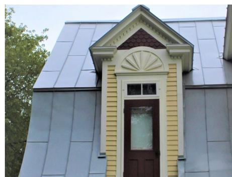
Détail de la toiture en tôle pincée (2018)
