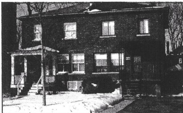
*Rénovation malheureuse de la partie à droite: les fenêtres à guillotine ont fait place à deux types de fenêtres différents. La galerie avec ses poteaux de bois a été remplacée par une galerie de béton avec poteaux d'acier.*
