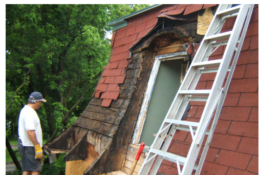
Lors du curetage, la démolition des lucarnes refaites vers 1967 a révélé leur forme ancienne. On voit bien l'arrondi en haut de l'ouverture.
