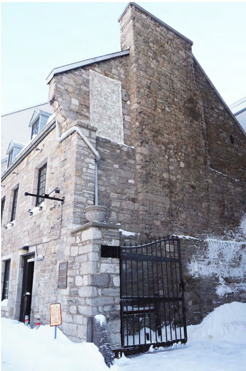
2. Ce mur coupe-feu est visible sur la rue Notre-Dame dans le Vieux-Montréal. Ce mur est exposé, mais auparavant il était mitoyen, la maison voisine ayant disparu.
