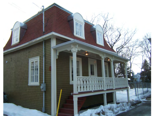
Fin des travaux extérieurs, hiver 2009
