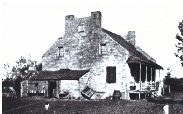
7. Cette photo de la maison Thomas-Brunet, située au cap Saint-Jacques, montre son état négligé vers 1920. On aperçoit une coulisse de suie le long du mur pignon, permettant de différencier la cheminée fonctionnelle de la fausse cheminée.
