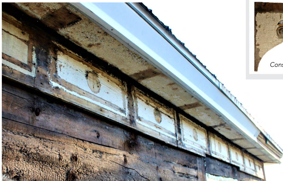
1. Dévoilement de l'empreinte des moulures de la corniche sous le revêtement de vinyle
