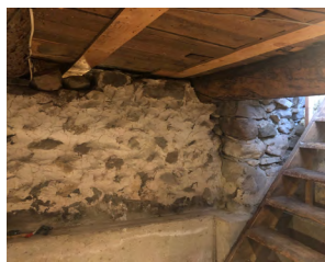
Assemblage des murs
