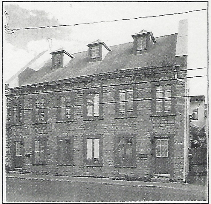
617-625, rue De La Salle. Vaste maison en pierre, construite en 1846. (Photo : Josée Vaillancourt)
