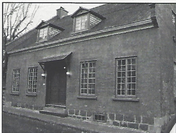
Maison Sauvageau-Gauthier 237, rue Saint-Ignace à La Prairie (Photo Marie-Lise Brunel)
