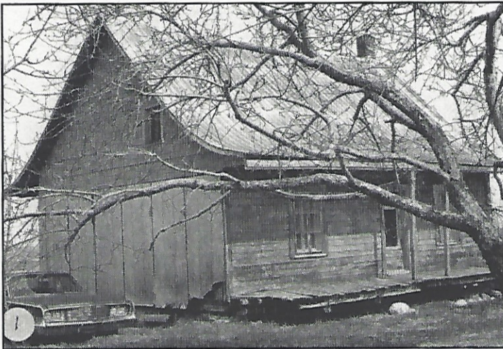
La maison en 1974 avant le début des travaux (Photo: Ronald DuRepos)
