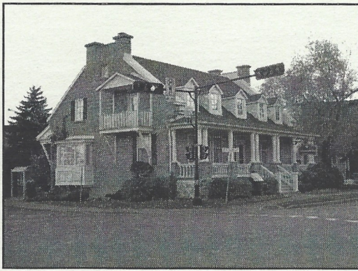
La Maison Lachaine, située rue Blainville Ouest à Sainte-Thérèse.
