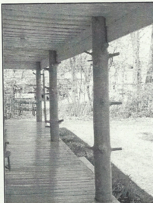
Poteaux d'origine de la Maison Merry (1821 à Magog).
