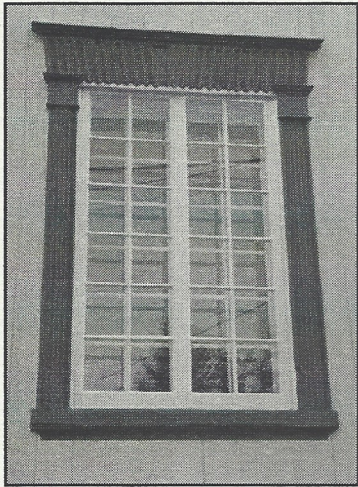
Fenêtre de la maison Berthiaume
