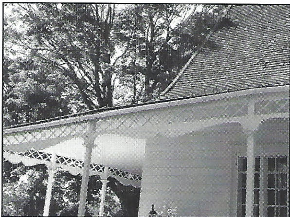
Remarquable galerie de la maison Fortier. (Photos : Agathe Lafortune)
