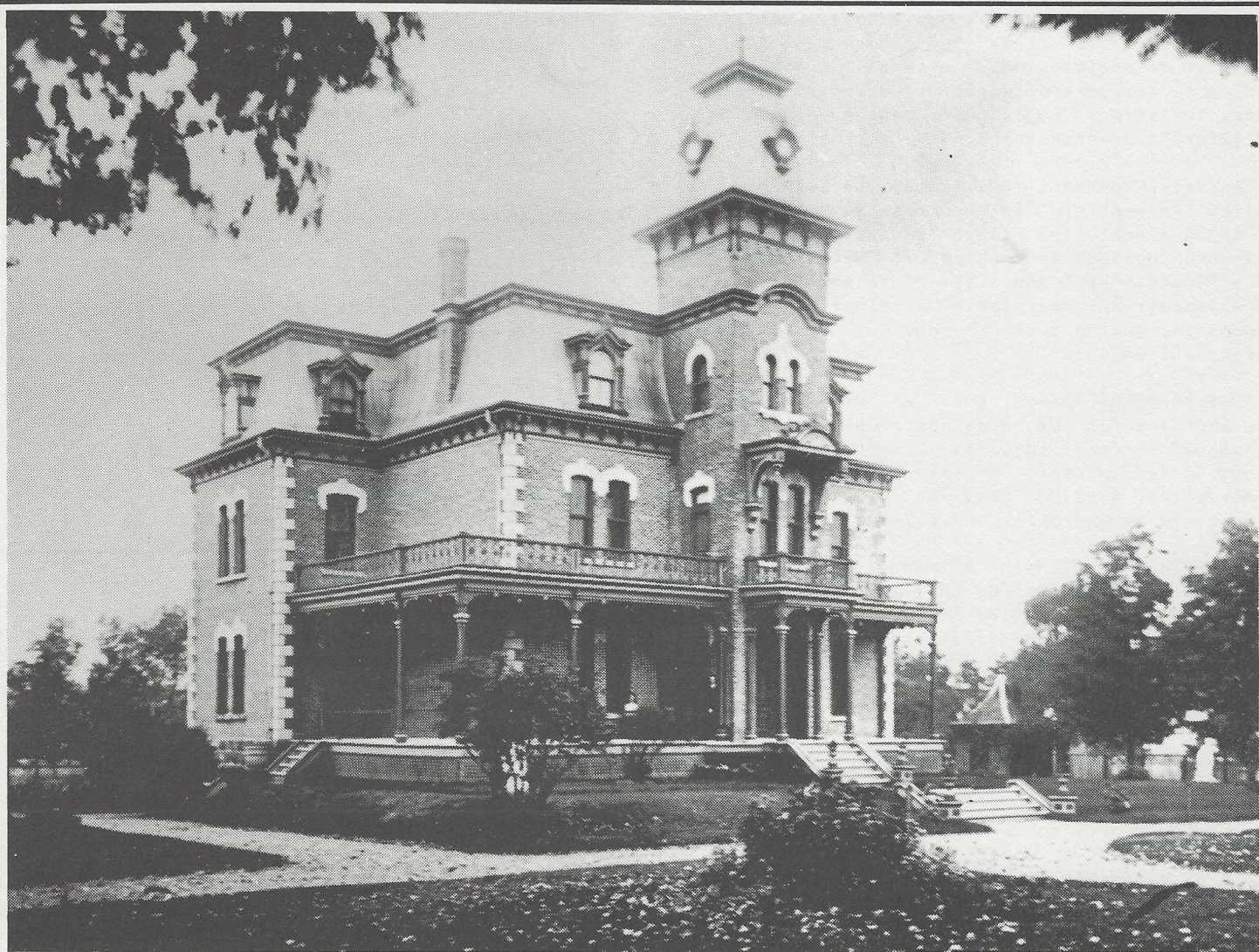
La maison Cormier à Plessisville
