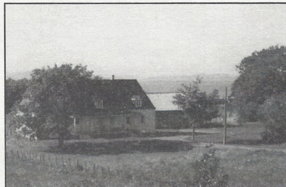
Maison de Richard Gaudreau, 295 des Pionniers ouest à l'Islet sur mer, construite par le seigneur Bélanger entre les années 1705 et 1715, rallongée en 1818.
