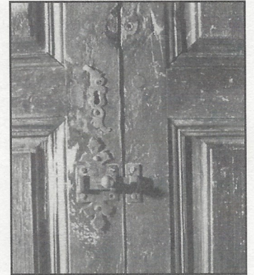
Verrou posé sur les vantaux d'un placard, Hôtel-Dieu (XVIII e siècle) - cf. George W. Leahy «L'ornementation dans la maison québécoise»
