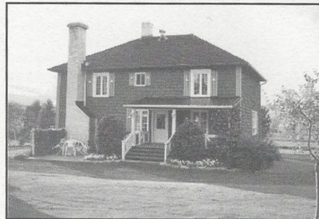
Vue arrière de la maison
