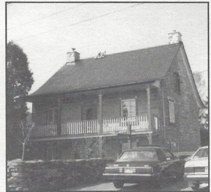
Maison de l'artisan qui, jadis, abritait l'atelier au rez-de-chaussée (Saint-Augustin)
