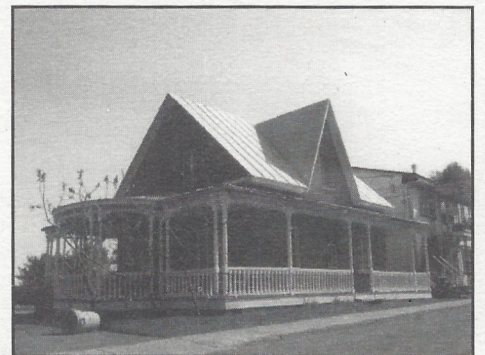
Maison de brique avec lucarne-pignon et galerie très ornementée. Notez l'ex-croissance de la galerie qui permet un espace pour les repas.
