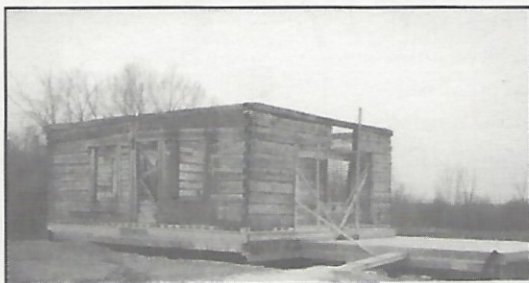
La maison en cours de reconstruction
