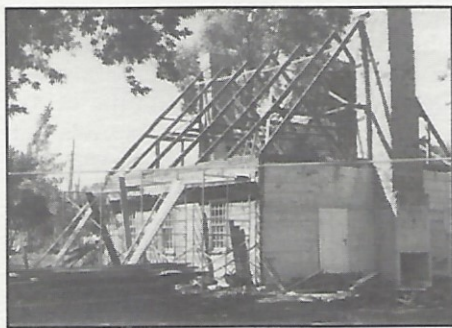
Aperçu de l'ampleur des travaux de restauration
