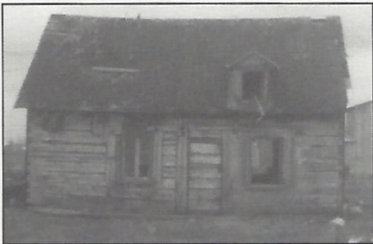
La maison lors du démontage
