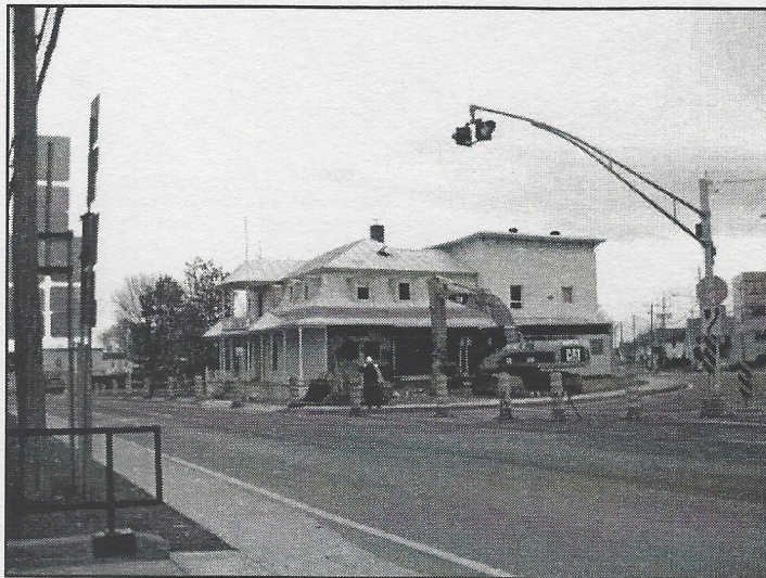
Vue d'ensemble du carrefour routier (Photo: Brigitte Grondin)
