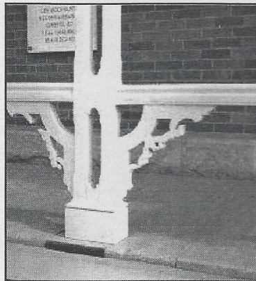
Galerie avec garde-corps formé d'une main courante supportée par des consoles sur une maison de style néo-Queen Anne de Louiseville. Ce modèle est courant en Mauricie.
