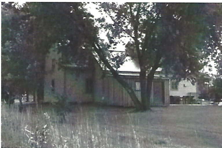
Vue arrière de la maison
