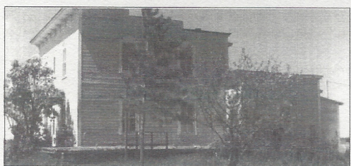
Maison rurale d'esprit néo-renaissance italienne 5275, boul. du Parc-Industriel
