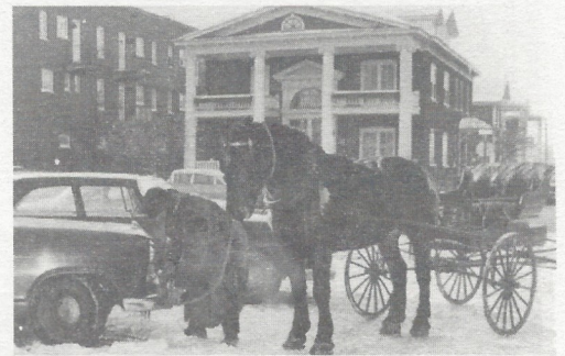
Résidence dessinée et construite en 1920 par Joseph Wilfrid Faucher, manufacturier de portes et fenêtres. (Archives de Bell)
