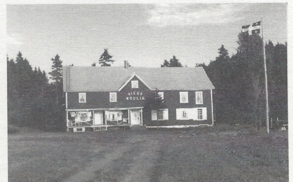
Le vieux moulin à farine (photo : F. Arsenault)
