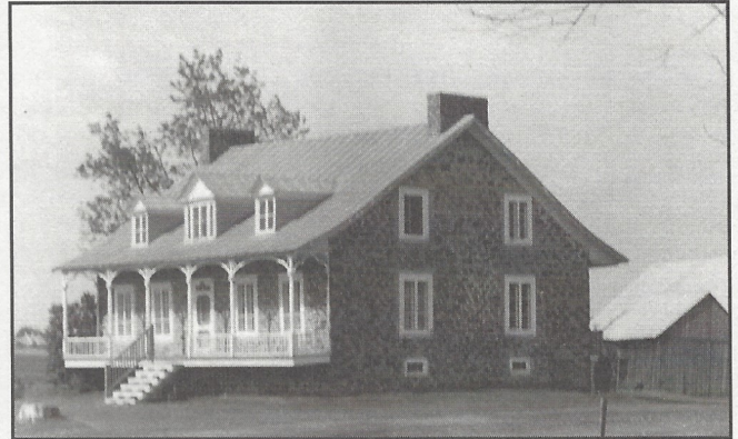
La maison d'Augustin Leblanc, construite vraisemblablement avec les pierres provenant des travaux d'agrandissement qu'il effectue entre 1850 et 1855 sur l'église de Saint-Grégoire. (Photo: Jean-Guy Gauthier)
