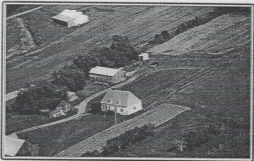
Vue aérienne de la maison Rocheron-Turcotte, à l'île d'Orléans (photo Pierre Lahoud).
