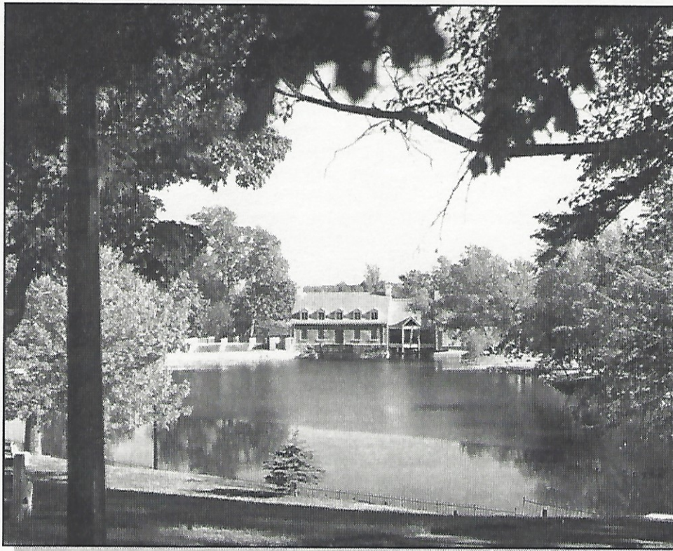
Les moulins de la chaussée vus depuis le surplomb de la rue Saint-Louis.
