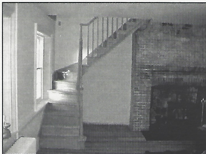
L'escalier et ses marches dansantes. Photo: Alain-Noël De Ronde
