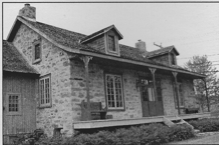
Maison Walker-McMartin (1848), œuvre d'Eustache LeBrun dit St-Antoine, maçon. (Photo : Jean-Marie Ferland)
