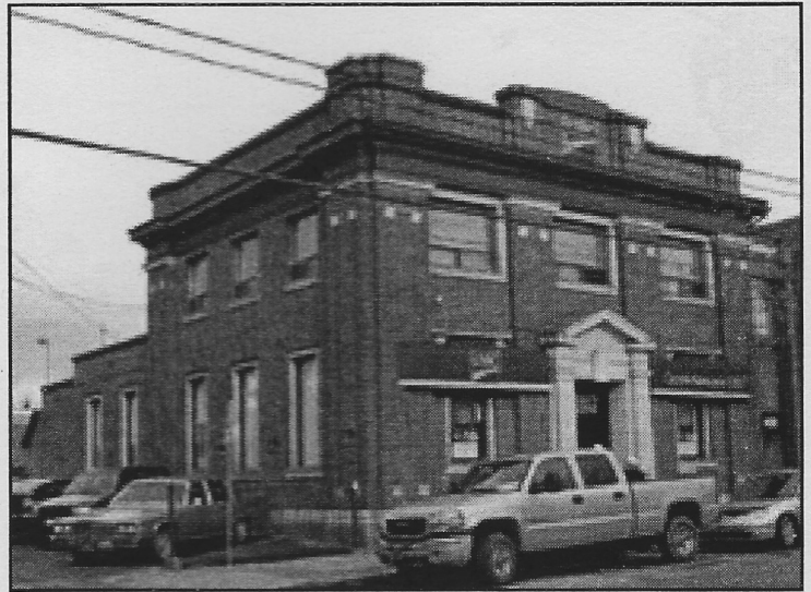
Rue Principale Ouest, Magog Type d'architecture commerciale
