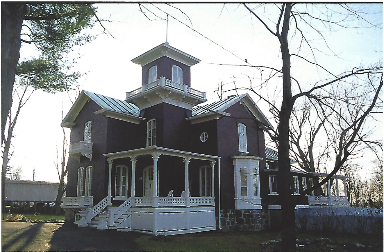
Maison de Victoriaville située rue Laurier Ouest Construite en 1877 selon les plans de l'architecte Louis Caron (Photo : Bergeron Gagnon Inc.)
