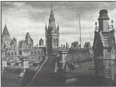
Les toitures d'ardoises de l'Hôtel du Parlement d'Ottawa, vers 1875. Les ardoises proviennent de la carrière Walton, près de Kingsbury. (Photo : Fond d'archives du Centre de l'interprétation de l'ardoise)
