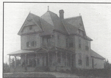
«Le Château»: maison du gérant de la carrière New-Rockland. Magnifique toiture en ardoise.
