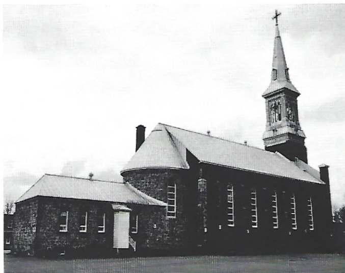
Photo 2 : Corps principal, abside et bâtiment de service de l'église de Saint-Constant (1882), en calcaire de Chazy
