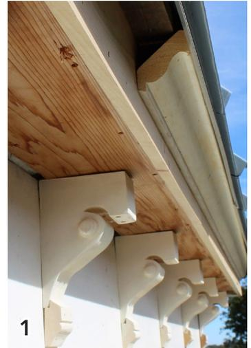
Reconstruction de l'avant-toit et insertion d'une doucine entre la planche de face et le larmier.
