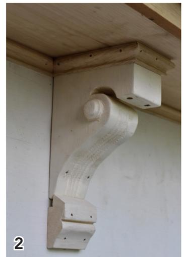
La console est visée (deux vis) au forjet de l'avant-toit et clouée au mur.
