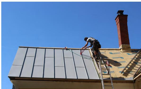
Le couvreur-ferblantier se servant d'une plieuse manuelle pour pincer les joints de chacune des feuilles de tôle (à joint debout).
