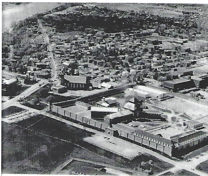
Une vue d'ensemble du Vieux-Saint-Vincent-de-Paul qui donne une idée de la place qu'occupe le Pénitencier. (Photo 1960)
