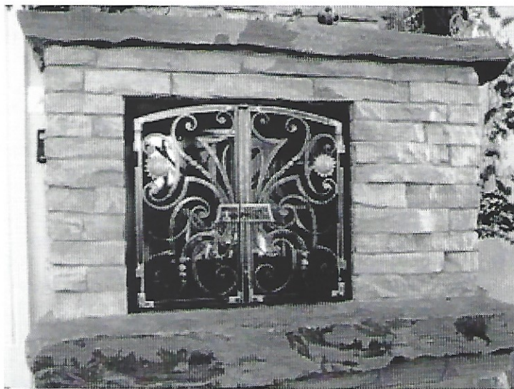
Grille de foyer double vantaux forgée. Techniques d'assemblage traditionnelles. Réalisation: La Forge d'Ilmarinen ferronnerie d'art. Crédit photo Romain Francès
