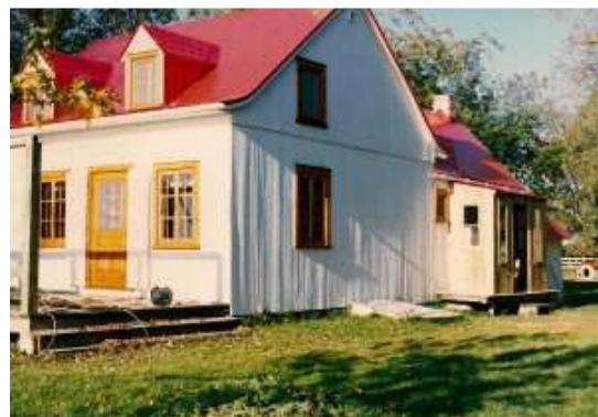
Lanoraie, maison Grenier, 1710, après la restauration. Photo : Monik Grenier
